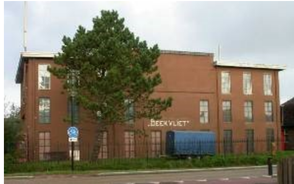
Figuur 42: Voorbeeld van een bollenschuur uit de jaren dertig van de twintigste eeuw, Herenweg 241 te Egmond aan den Hoef.
