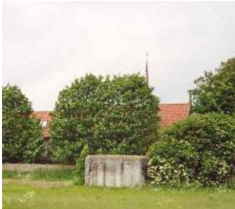
Figuur 101: Bunkers liggen verspreid over het gehele grondgebied van de gemeente. Verder zijn er draketandversperringen te vinden, zoals deze bij het Karmelieterklooster aan de Herenweg bij Egmond aan den Hoef.
