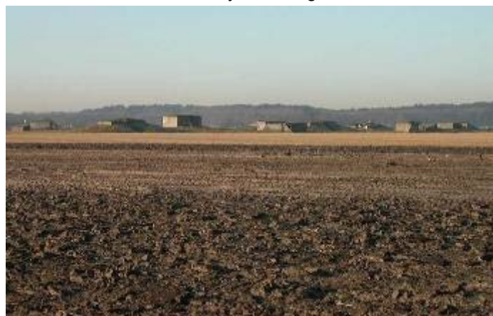
Figuur 123: De gebouwen van vliegveld Bergermeer bestaan nog. De gebouwen zijn lange tijd door het Ministerie van Defensie gebruikt. Nu ze leeg komen te staan zal een nieuwe bestemming gevonden moeten worden.
