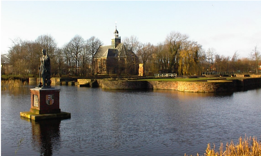
Figuur 14: Van het Slot van Egmond resteren nog de funderingen. Deze zijn in de jaren dertig van de twintigste eeuw opgemetseld en van een afdekking voorzien.
