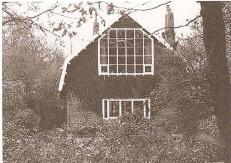
Figuur 76: Buerweg 19 te Bergen. In deze atelierwoning heeft de schilder Charley Toorop gewoond en na haar zoon de schilder Edgar Fernhout. De woning is in 1921 gebouwd naar ontwerp van A.C. Klomp en P. Kramer. Het grote raam, dat op het noorden is georiënteerd, is kenmerkend voor atelierwoningen. (Bron: Van Leeuwen & Vroom, 1997, p.27)
