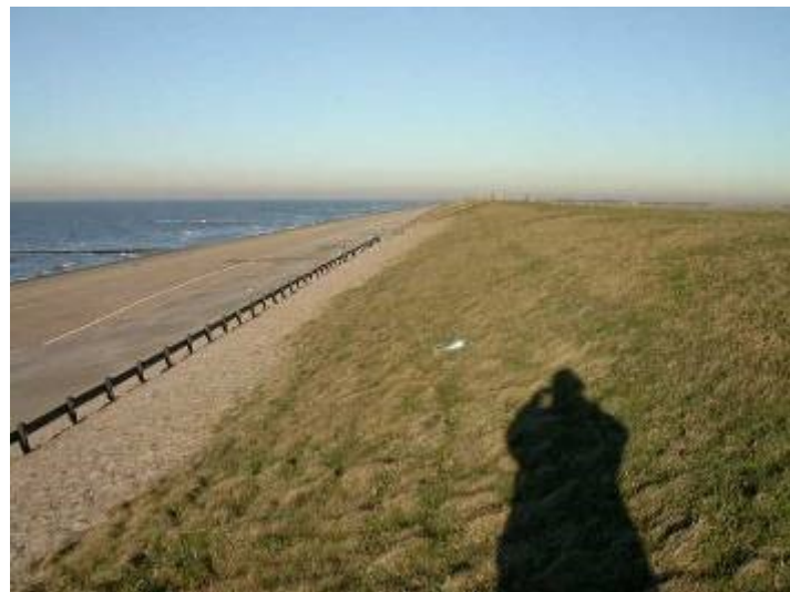
Figuur 12: De Hondsbossche Zeewering ligt sinds 1792 op de huidige plaats. In de jaren tachtig van de twintigste eeuw is de dijk op Deltahoogte gebracht.
