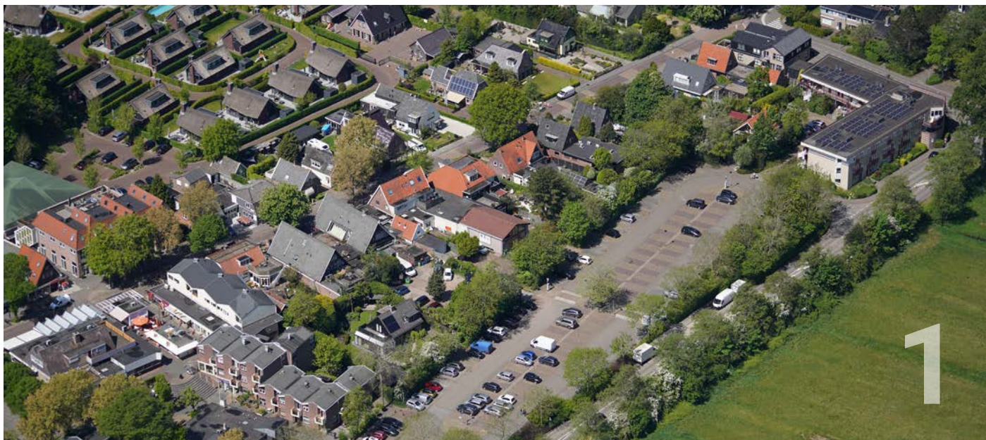
Luchtfoto deelgebied 1: Parkeergarage huidige situatie
