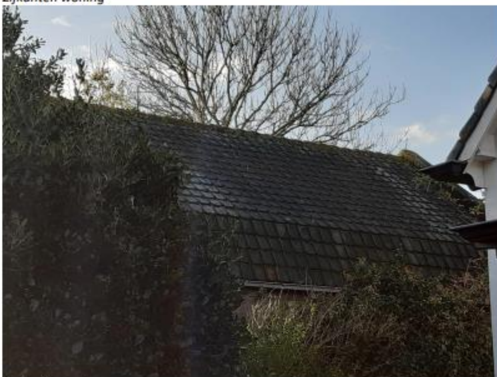
Dak van woning
