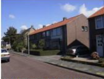
de bebouwing dient op enige afstand van de weg te staan
